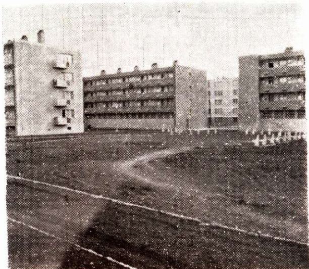
Az épülő új városnegyed
